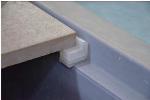
Die Distanzaufleger haben eine Gesamthöhe von 20 mm und sind an der Unterseite mit zwei 5 mm starken Abrisskanten ausgestattet, um die Höhe der Auflager an die Steinstärke anpassen zu können. Standardmäßig sind die Distanzaufleger für 20 mm Steinstärke geeignet, entfernt man eine bzw. beide Abrisskanten kann die Steinstärke 25 mm bzw. 30 mm betragen.
